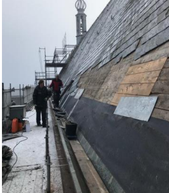
Foto: restauratie leiendak
