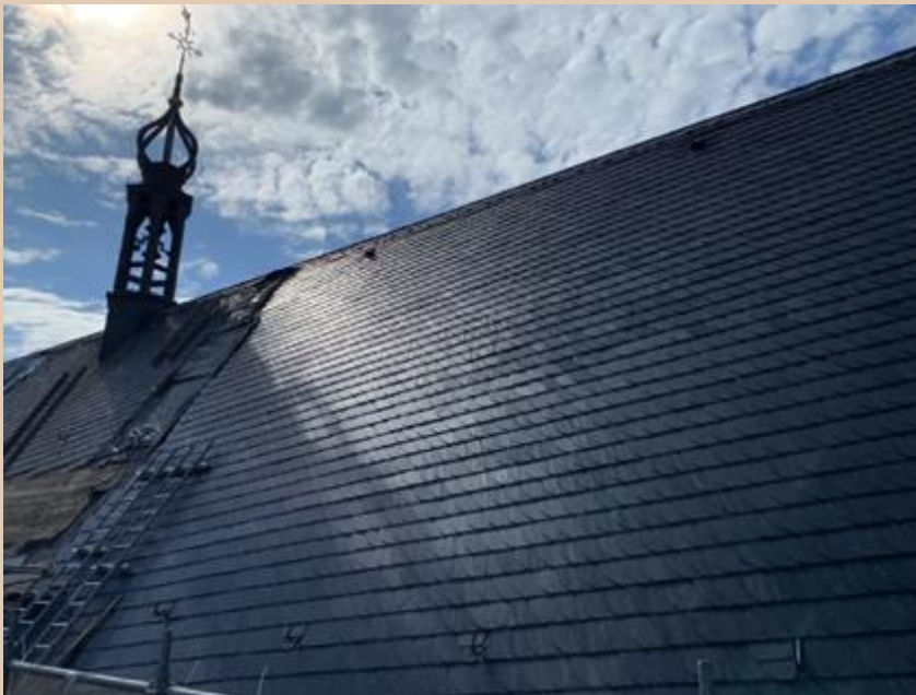
Het nieuwe dak
