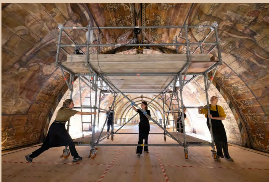
Verplaatsing van de grote rolsteiger
